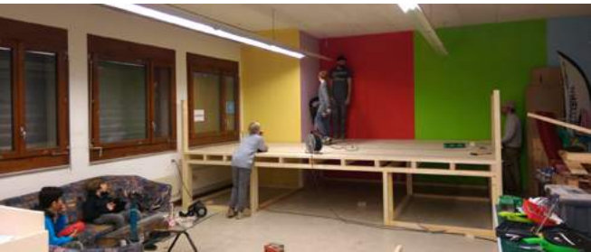
Jugendliche beim Podestbau im Februar – Der Jugendtreff wird quasi um ein Stockwerk erweitert.
