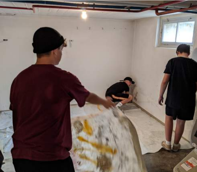
Umbau Gameroom im Keller
